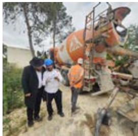
המפקח הרב ישראלי קוט בפיקוח על הכנת הבטון לקראת יציקת מקווה, כדי לוודא שיהיה מסוג דאוי ולא זחילה בעתיד
